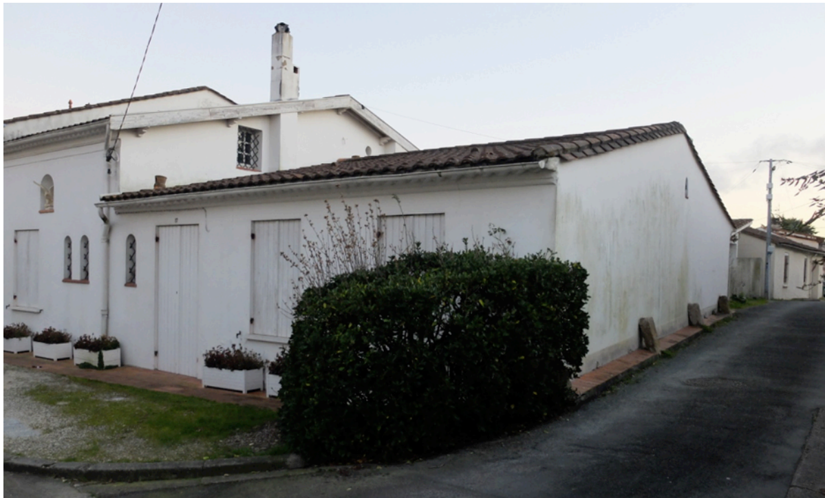
Maison Pérey, n° 19, rue du Cap-de-Haut (février 2020). (Coll. Part.)
